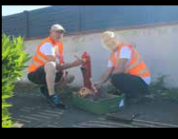
Remise en état des poteaux d'incendie
