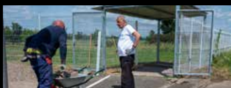
Terrassement préparation pour carport du CAVO
