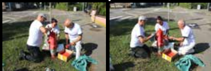
Remise en état des poteaux d'incendie
