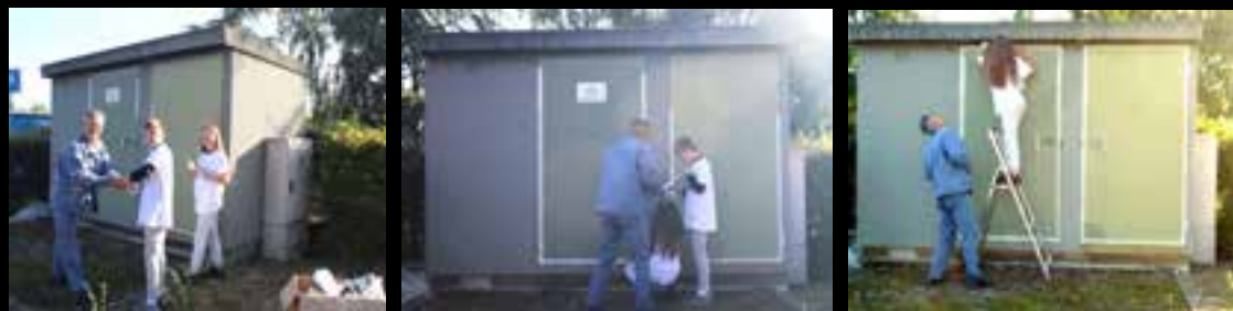
Peinture de transformateurs
