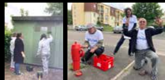
Remise en état poteaux d'incendie et transformateur
