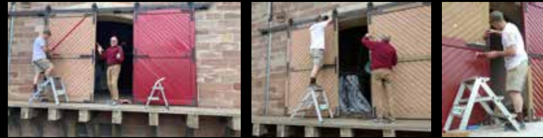
Peinture hangar de la gare
